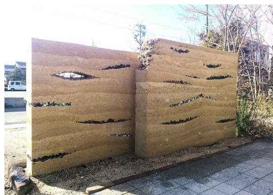
Zdi z vrstveného probarvovaného betonu
