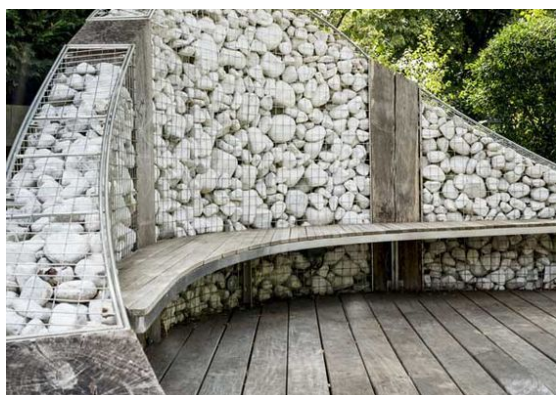
Možné tvarování gabionových košů
