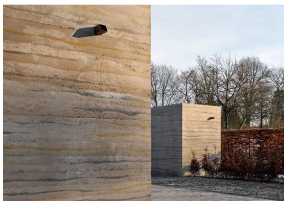
Zdi z vrstveného probarvovaného betonu
