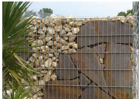
Ukázka možného skládání kamenů do gabionových košů
