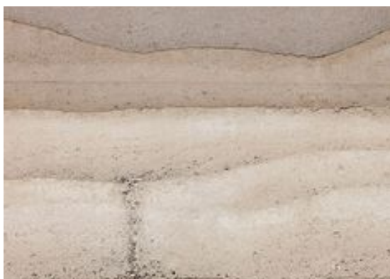
Zdi z vrstveného probarvovaného betonu - detail
