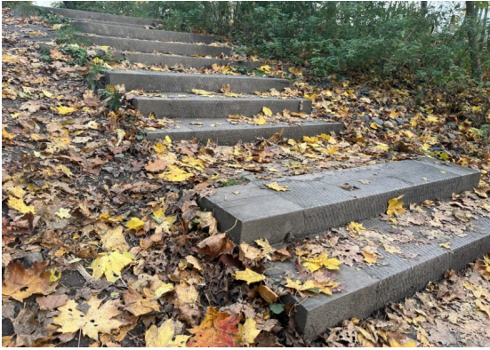
Dřevěné schody - prážce
