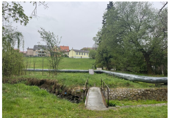
Pohled na vrch Pergál přes lávky
