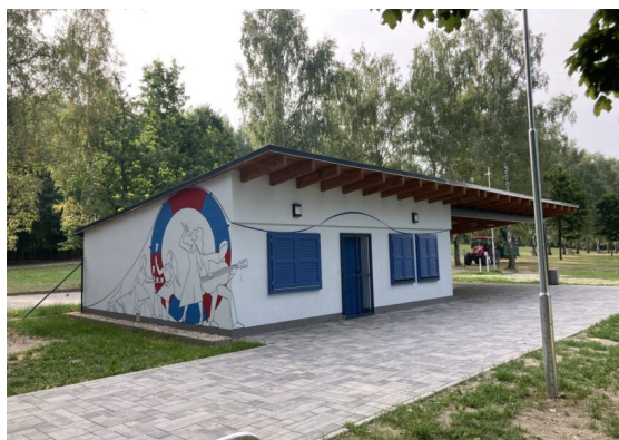
Stávající rekonstruovaný objekt občerstvení
